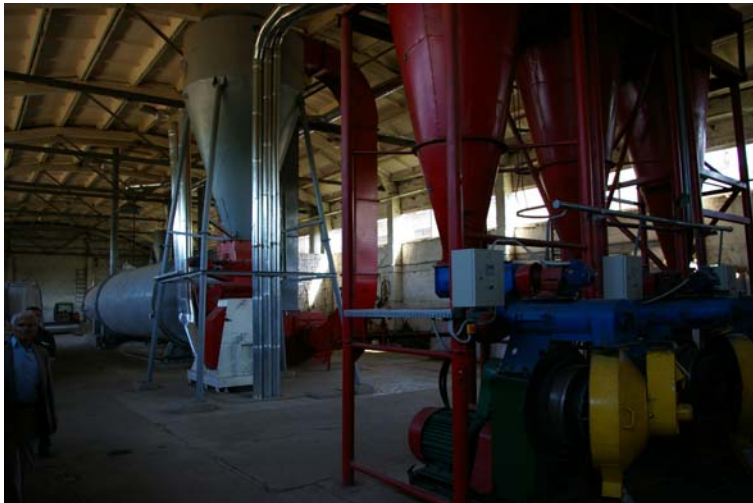
Фото 130 Завод по производству гранул из древесных отходов
