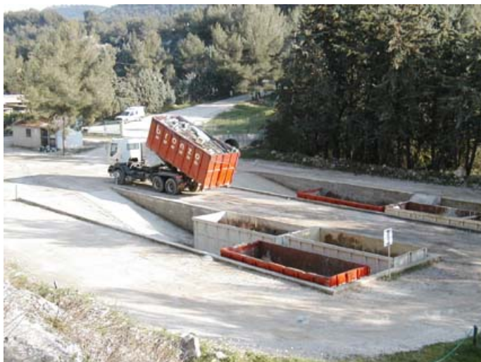
Фото 83 Мусороперегрузочная станция ниже уровня дороги
