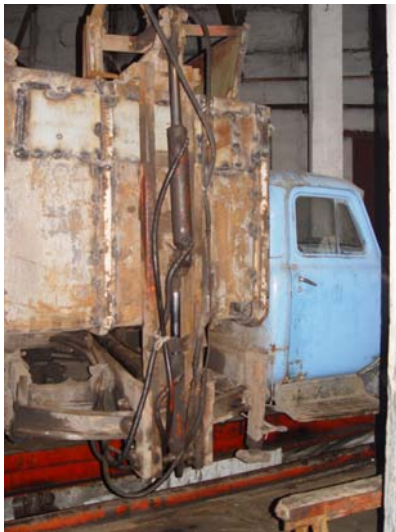
Фото 50 Ремонт кузова с заменой отдельных элементов железного листа
